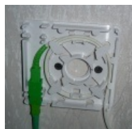
Оптическая розетка без крышки
