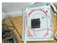
Оптическая распределительная коробка без крышки
